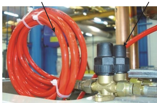
Válvula de corte de fluido frigorígeno
